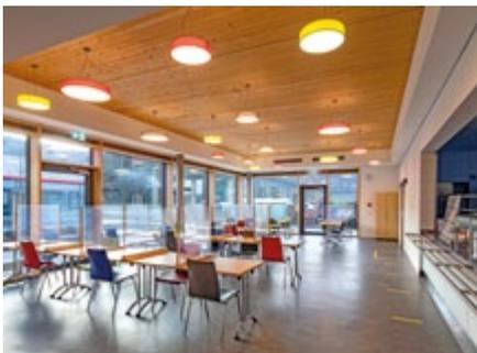
Ca. 6.000 m<sup>2</sup> KIELSTEG Holzbauteile kamen bei den zwei Neubauprojekten zum Einsatz; darunter auch hochtragfähige Elemente mit über 22 m Spannweite. Geplant wurden die beiden Projekte vom Architektur- und Planungsbüro APPArchitekten in Lauda-Königshofen.
