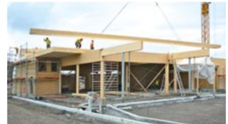
Das neue Autobahnrestaurant ist ein zeitgemäßer Bau, dessen Energiebereitstellung ganz im Zeichen des Klimaschutzes steht. Zur Reduktion von CO<sub>2</sub> beim Bau wurde ganz auf den Baustoff Holz gesetzt. Die Wände sind eine Holzriegelkonstruktion, die Dachschale bilden KIELSTEG Elemente die von BSH Trägern in drei Achsen getragen werden.
