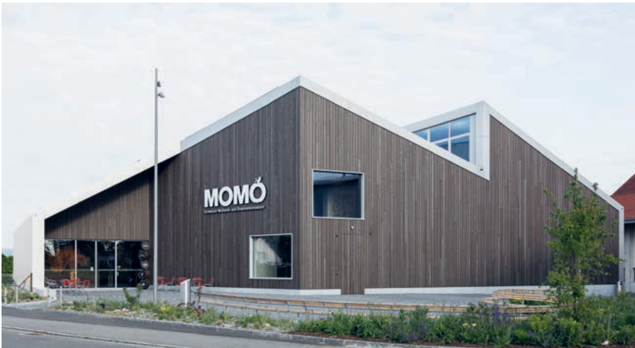
Architektonisch verbindet das MoMö das Bild einer traditionellen Scheune mit Elementen industrieller Architektur. Ein markantes Merkmal ist die 885 Quadratmeter grosse Holzfassade.
