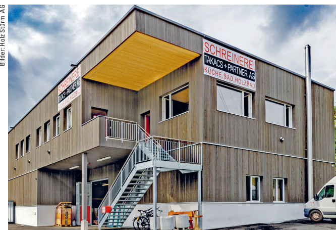
Beim Neubau der Schreinerei Takacs + Partner AG in Russikon (ZH) wurden sowohl Brettsperrholz- als auch Kielsteg-Bauteile verwendet.
